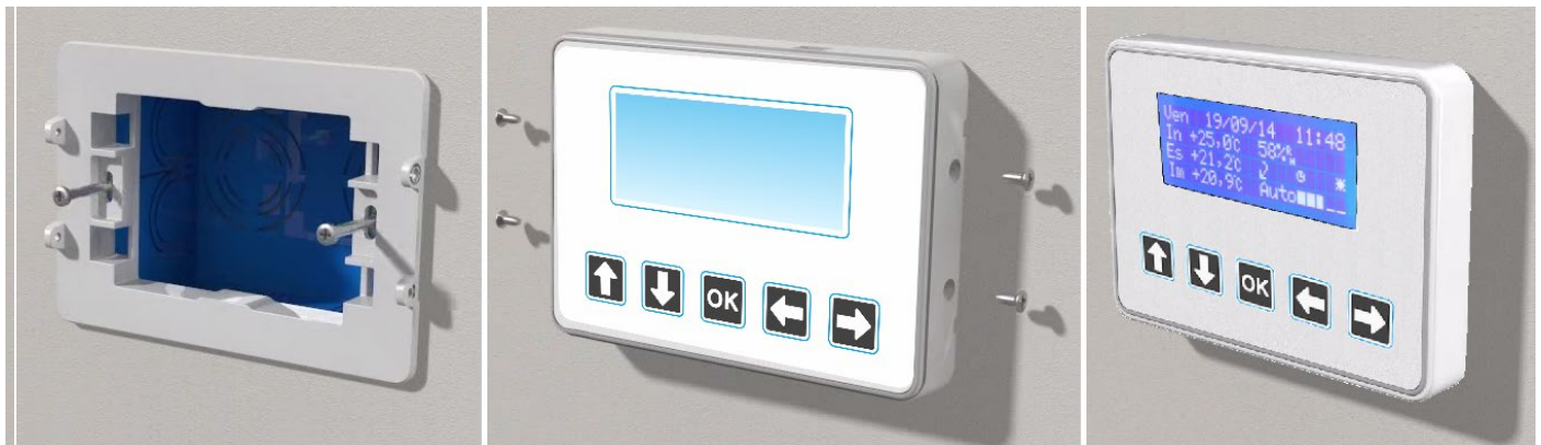
Figura 2 - Sequenza installazione controllo remoto LCD
